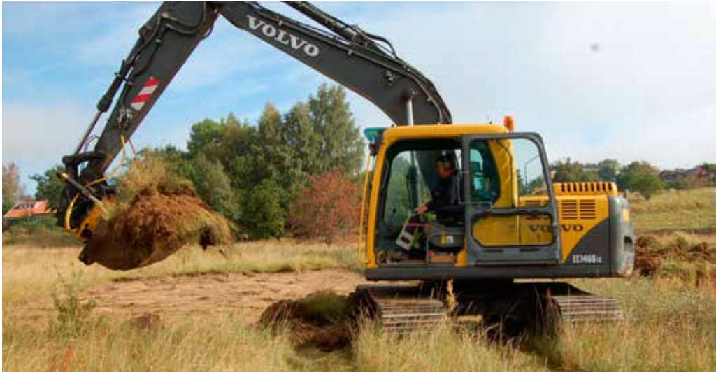
Genom att schakta fram sandblottor öppnas marker som sandens arter återigen kan etablera sig på. Här ser vi grävning av sandblottor vid Torna Hällestad, Skåne. FOTO: Gabrielle Rosquist.
