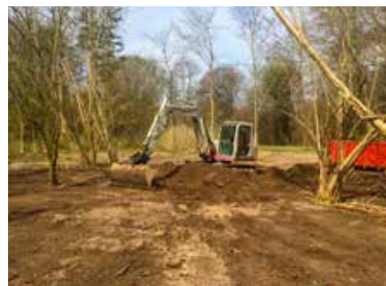
Det översta jordlagret med förna och flis skrapades av och fördes bort i containrar.
